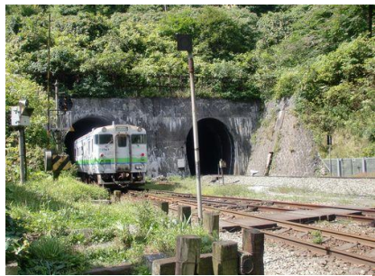
小幌駅のトンネル
